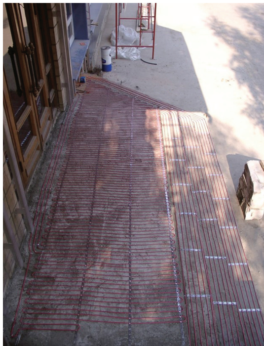
Фото 3. Монтаж системы снеготаяния на крыльце.
