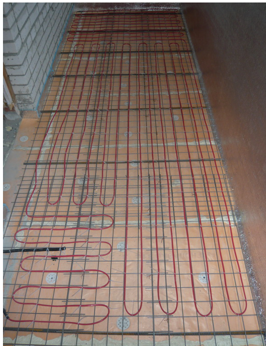
Фото 1. Монтаж теплого пола на утепленном балконе.
